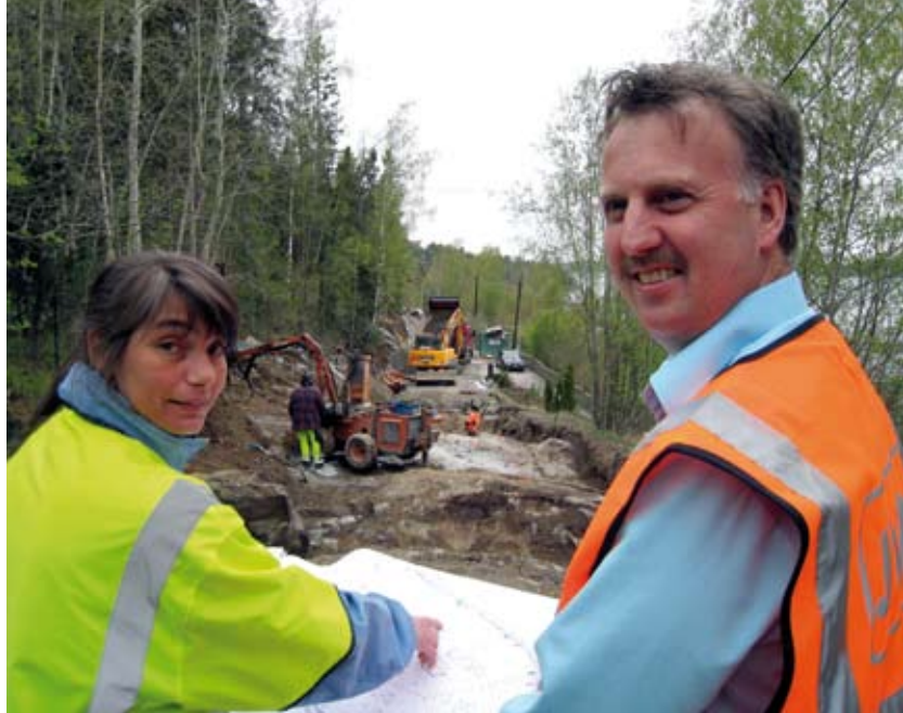
Nyanläggningschefen Sven Brodin i samråd med Ingmarie Brännvall, arbetsledare hos entreprenören JVAB, vid tidigare vägarbeten. Foto: Christine Salomonsson
