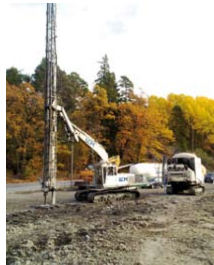
Kalkstabiliseringen av Edinsborgskurvan och på Fiskarrovägen, hösten 2010. Foto: Sven Brodin
